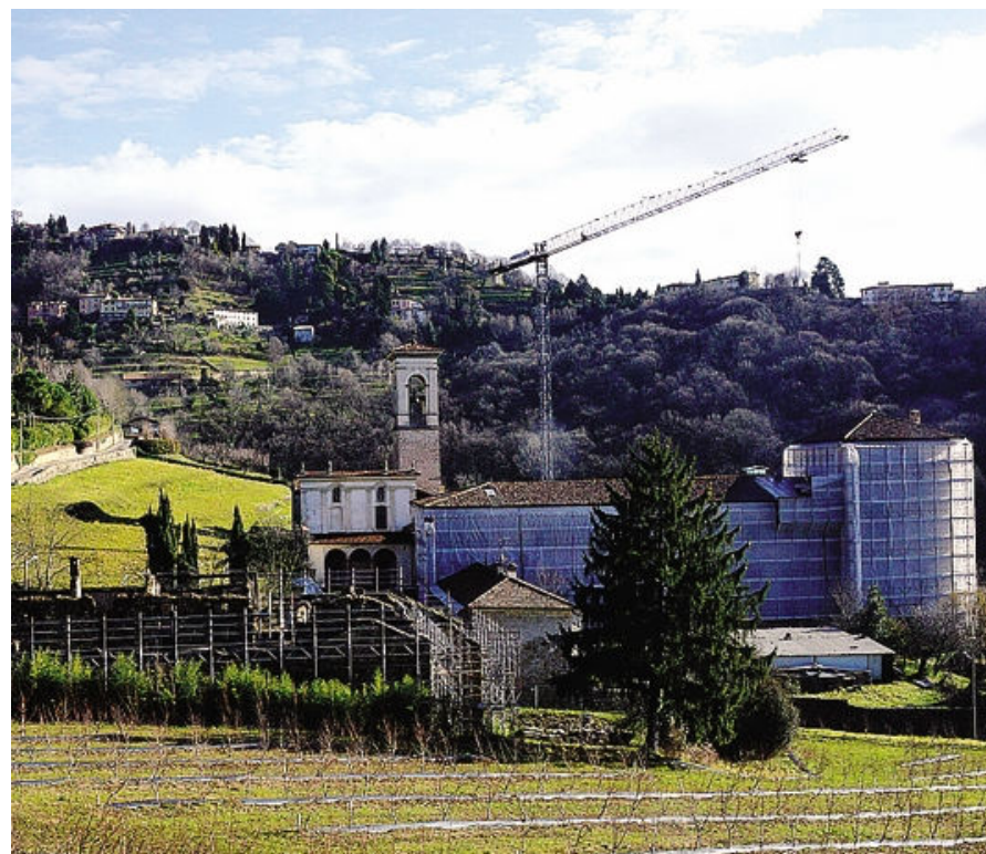
Ristrutturazione in corso delle facciate dell'ex monastero di Astino. E si lavora anche per l'Orto FOTO BEDOLIS
